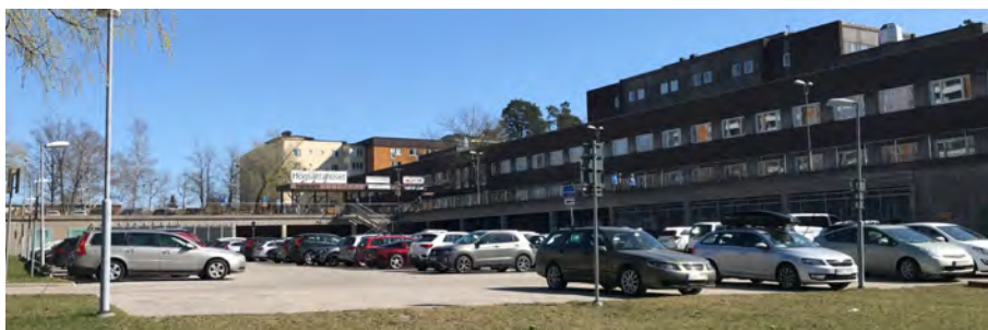
Högsättrahusets entré med parkeringsplatser framför.
