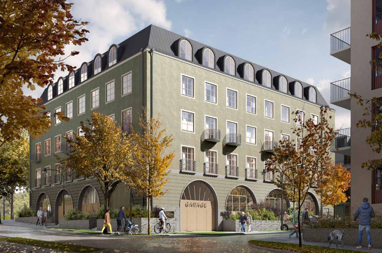
Vy från korsning Högsåtravägen och Mittenvägen. Byggnadens norra och västra fasad. Garageport och port för in- och utlastning till verksamheten i byggnaden. Granitmurar ramar in den förhöjda förgårdsmarken. Bild: Brunnberg och Forshed.
