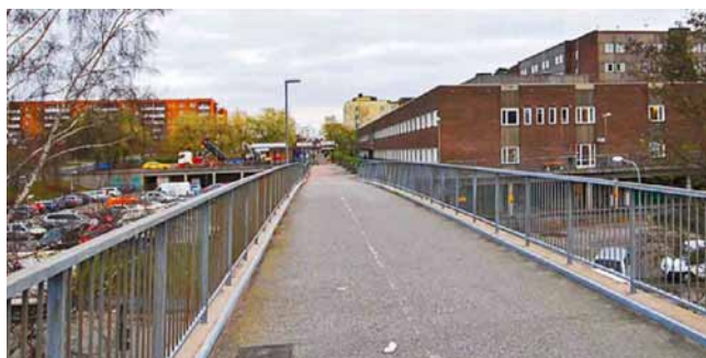
Befintlig gångbro över Läroverksvägen och Lerbovägen.
