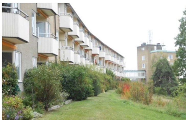
Borggårdens västra länga och höghuset i fonden. På bilden syns den sammanlänkande matargången mellan husen.
