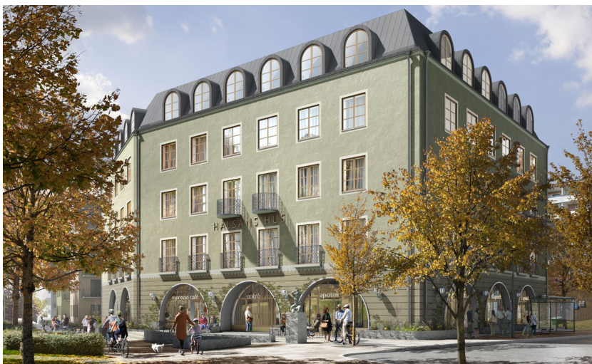
Hälsans hus sett från bussvändslinjan. I bilden syns torget och Hälsostråket vänster i bild. Bild: Brunnberg & Forshed.
