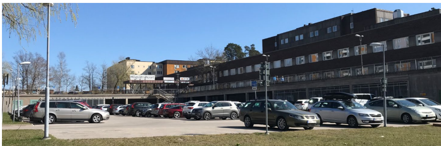
Högsätrahusets entré med parkeringsplatser framför.
