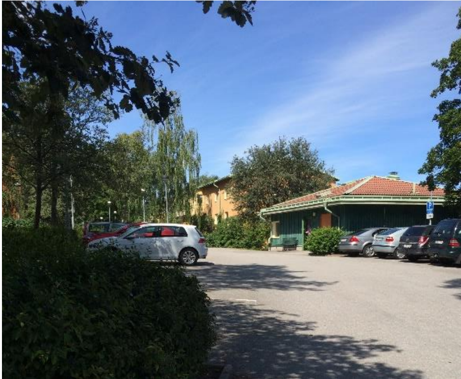
Tvättstugan och parkeringsytan.
