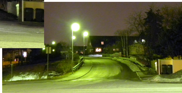
Blåklockevägen innan bytet, bilden tv med ny belysning.
