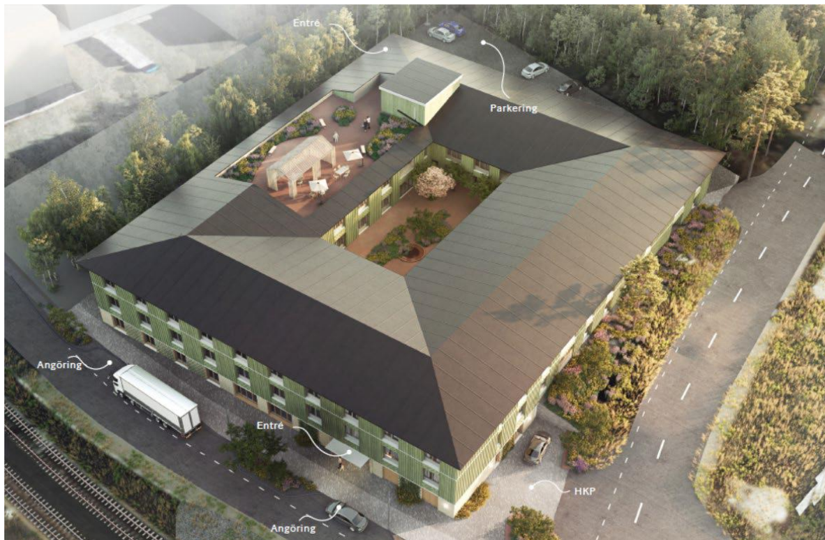
Figur 15 Visionsbild, bilden är framtagen av Krook & tjäder arkitekter till ansökan om planbesked och är inte den slutgiltiga gestaltningen.
