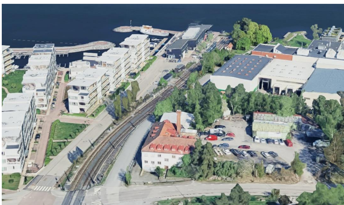
Figur 11 Fastigheten Lyftkranen 2 sedd från väster (Googlemaps 2025).
