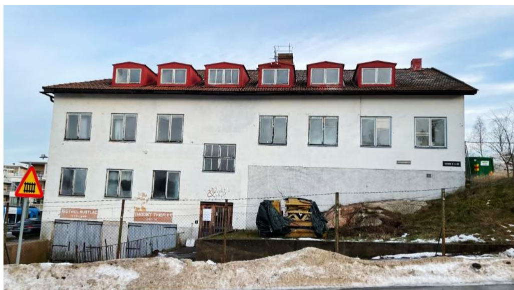
Den "trappande" sockeln på den vita byggnaden och det synliga berget i dagen vittnar om fastighetens kuperade karaktär.
