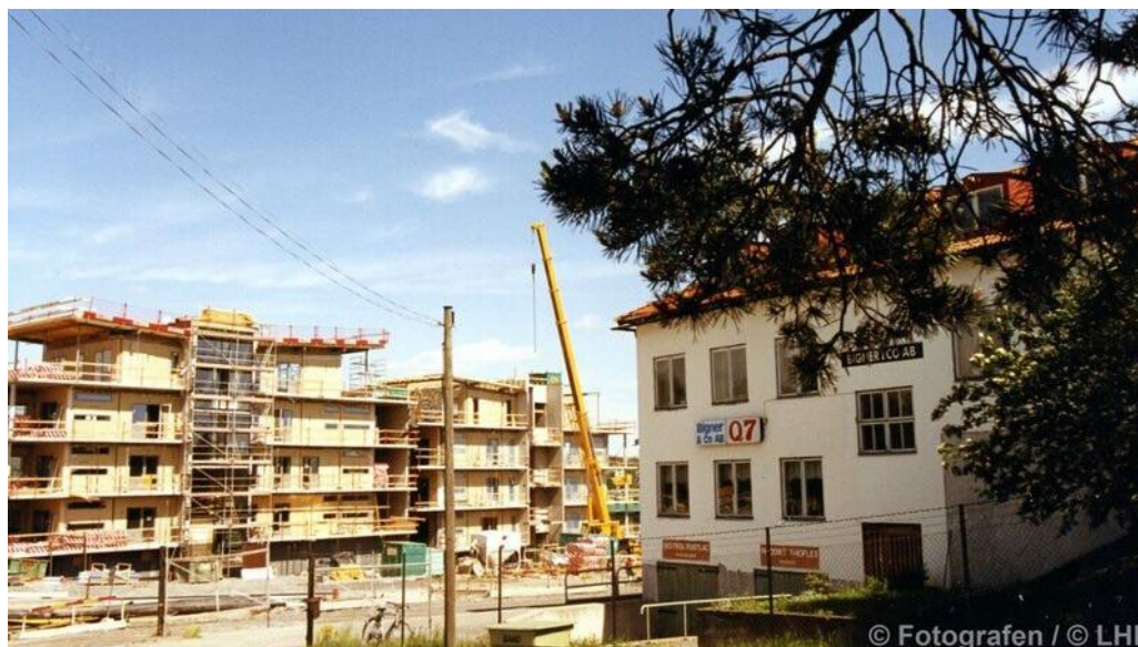
Foto från tidigt 2000-tal. Verksamhetshuset på Lyftkranen 2 till höger. Pågående byggnation av Bostadsrättsföreningen Gåshaga Pirar 1.
