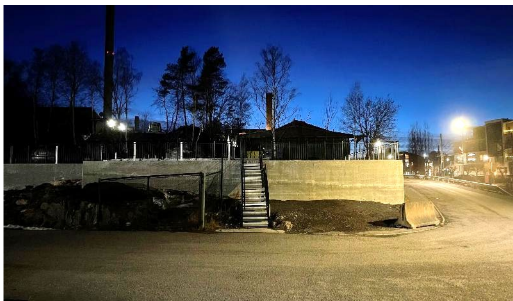
Vy från infarten till Bonvers lastgård i riktning mot väster. I vy bakom personalparkeringen som är byggd på en egen plåtå, syns Lyftkranen 2 i mörker.
