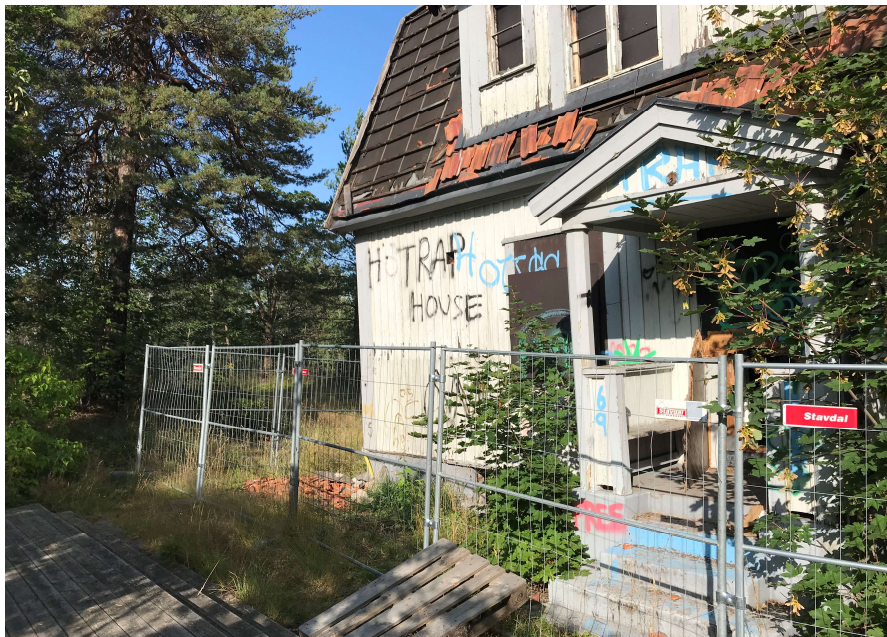
Byggnaden på fastigheten Lejonet 43 sedd från Floravägen sydost om byggnaden.
