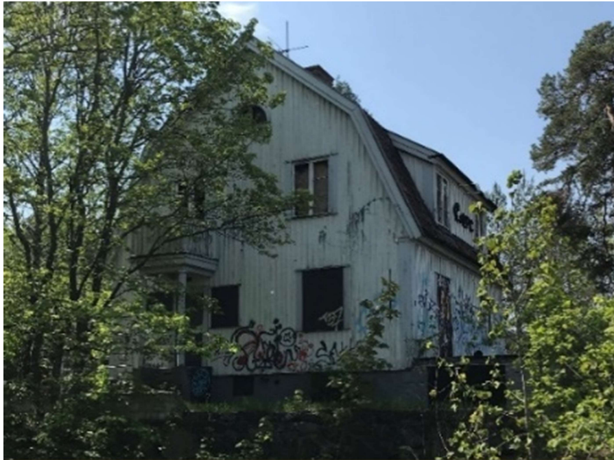
Byggnaden på fastigheten Lejonet 43 sedd från Floravägen nordost om byggnaden.
