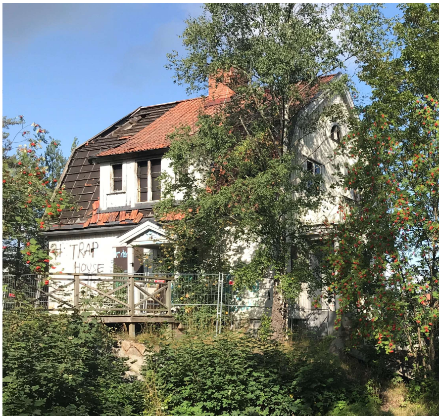
Byggnaden på fastigheten Lejonet 43 sedd från Floravägen sydost om byggnaden.
