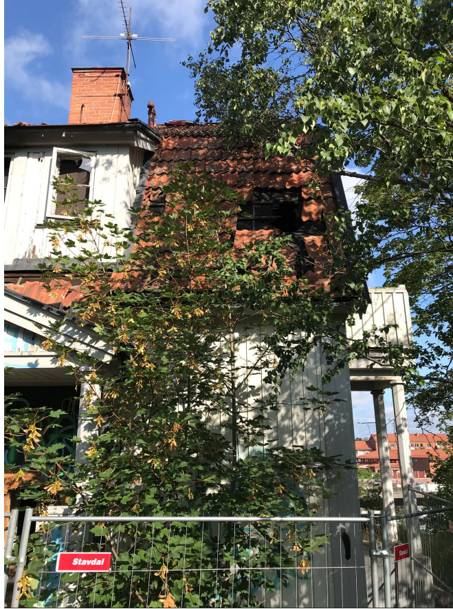
Byggnaden på fastigheten Lejonet 43 sedd från Floravägen sydost om byggnaden.
