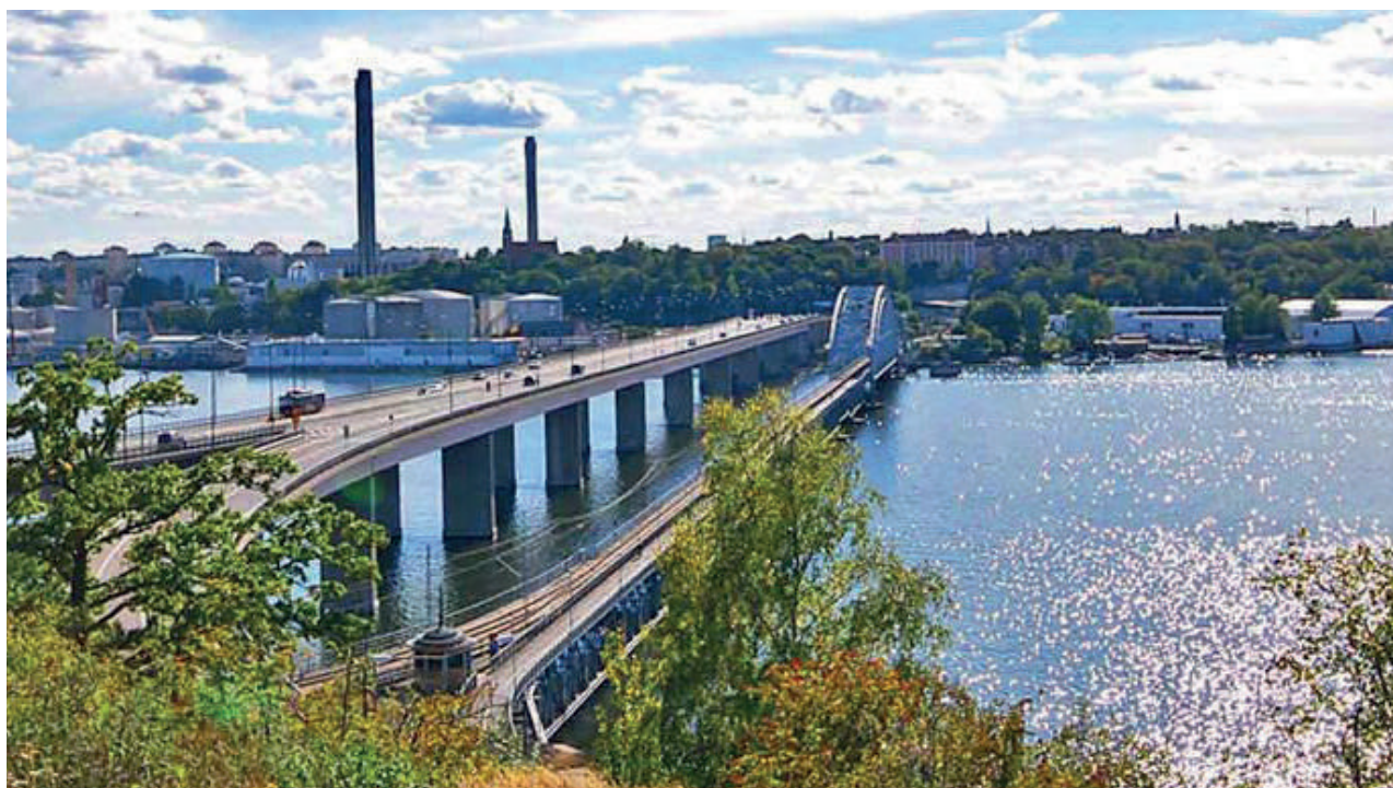
▲ Gamla Lidingöbron och Lidingöbron, en karaktärssiluett för Lidingö och Lilla Värtan. Vy från Torsviksberget på Lidingösidan över mot Hjorthagen och Ropsten. Gamla Lidingöbron invigdes 1925, det var Lidingös första fasta bro som ersatte äldre flottbroar. 1971 invigdes Lidingöbron. Den nya bron med dess förgrenade stora påfarter, innebar stora förändringar i Torsvik. All den äldre bebyggelse som låg kring infarten mot Stockholmsvägen revs.
