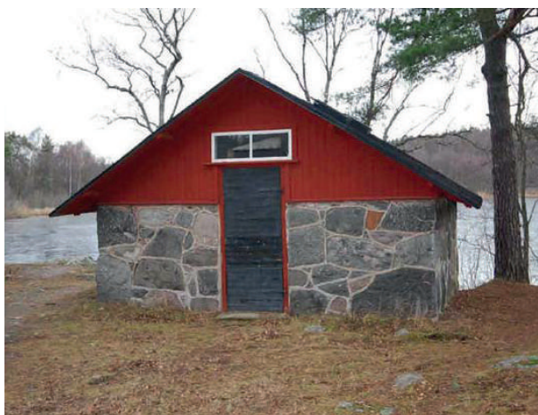
▲ Fyrverkerifabriken från 1880-talet är ett småskaligt industriminne, en särpräglad industrimiljö belägen vid Stockbysjön. Historiskt sett hör den samman med den närliggande sommarvillan Finedal.
