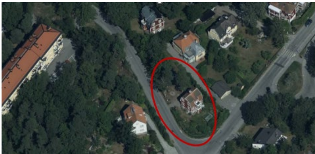
Flygfoto över området som visar fastigheten Vitmossan 8 och omkringliggande bebyggelse. Planområdet är markerat med röd oval.
