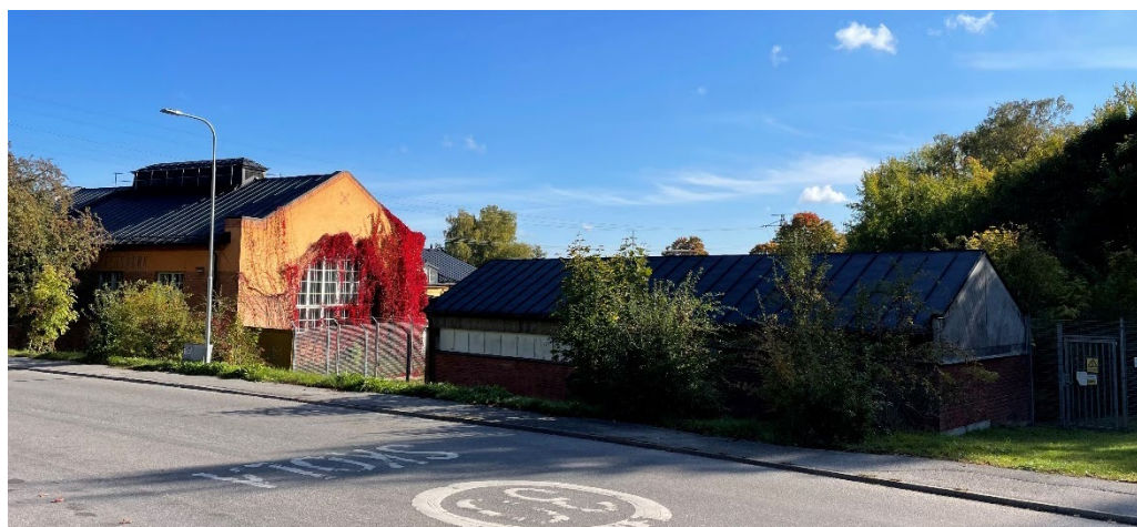
Fastigheten Kyrkvaktaren 2 sedd från Stockholmsvägen. Elverket från 1910 med stort, tätspröjsat gavelfönster. Fördelningsstationen med falsat plåttak och tegel- och betongfasad.
