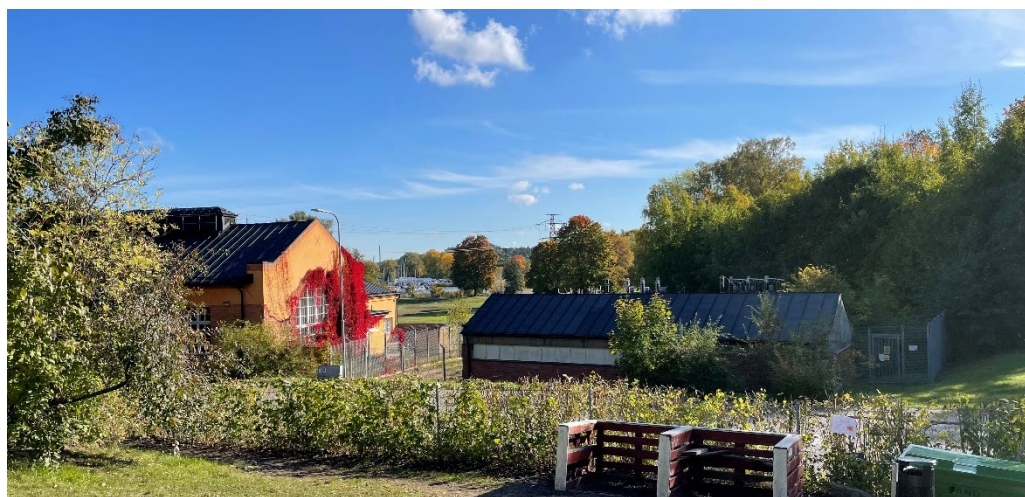
Vy från Klockargårdens skolgård. Fördelningsstationens byggnad till höger, Elverket/musikskolan till vänster.
