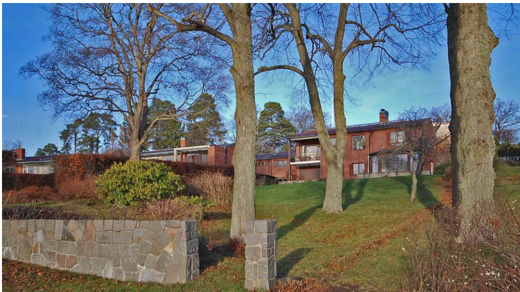
Sjösluttningen med från vänster Mölnastranden 4 uppförd 1958 ritad av arkitekter Björn Howander och Olle Stark, Mölnastranden 5 uppförd 1957 och ritad av arkitekt Stig Ancker samt Mölnastranden 6 från 1957 ritad av arkitekt Harry Åberg, alla i rött tegel. Fasaderna är i regel mer slutna mot vägen och öppnar upp sig mot sjösidan.
