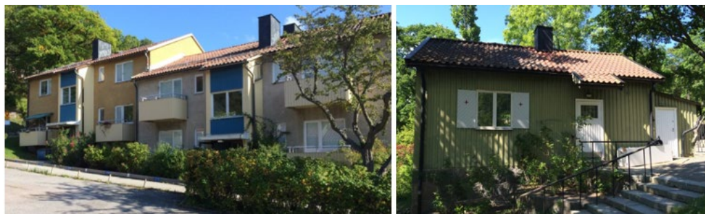
Flerbostadshuset vid Elfviksvägen till vänster och Gröna stugan till höger.
