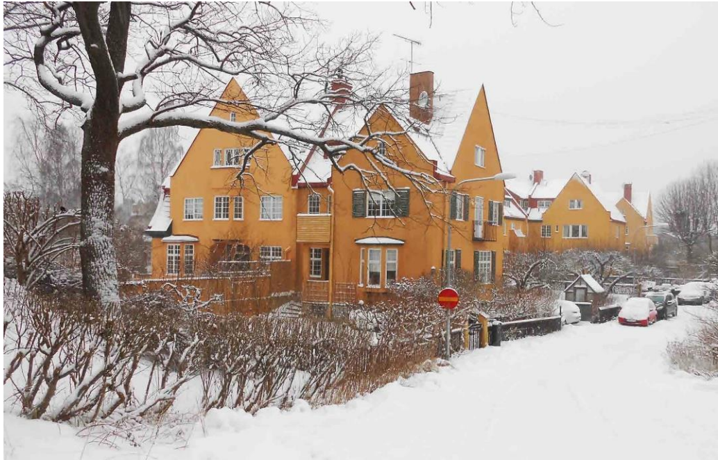
Tegen större. Vy från söder mot de större tvåvåningsradhusen från 1908-1909 som täcks av ett spetsigt sadeltak med ett tidstypiskt närmast obefintligt taksprång.
