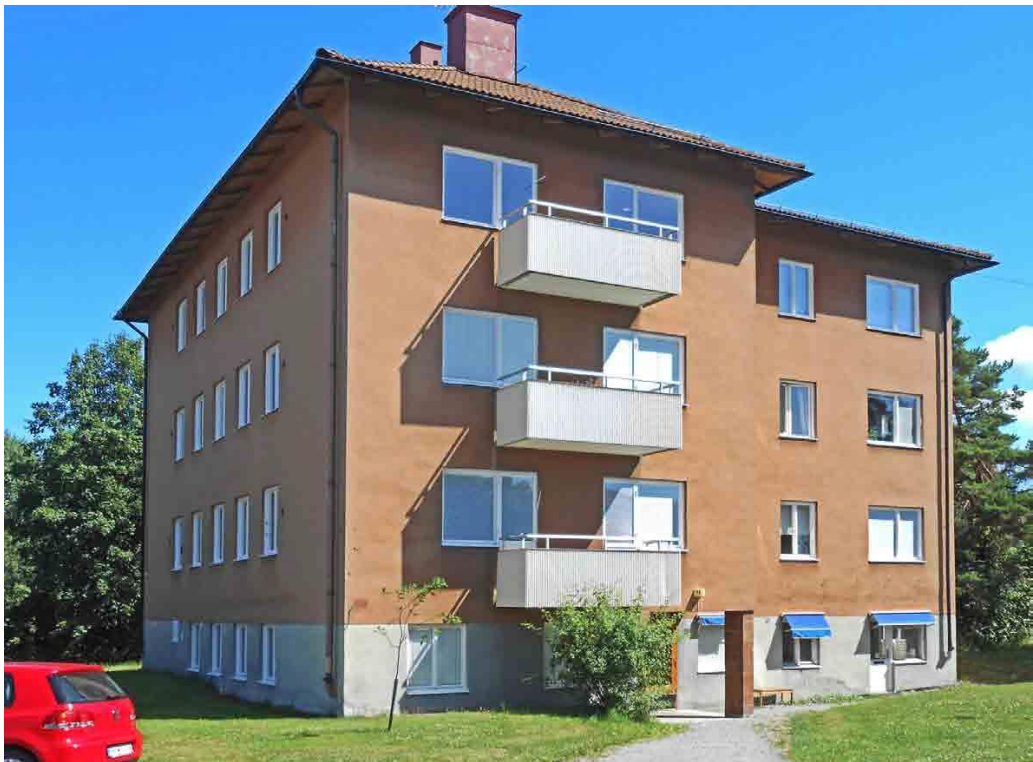
Bore 1 ritades 1945 av arkitekten Björn Hedvall. Exteriören är väl bibehållen sedan 1940-talet, fränsett sentida typ av balkongfronter.
