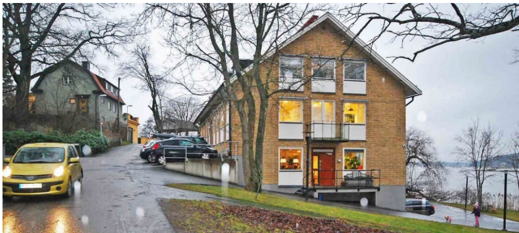
Bebyggelse längs Grenstigen. Till vänster Islinge udde 5 från 1928, till höger den modernistiska kontorsbyggnaden Islinge udde 9 från 1960.
