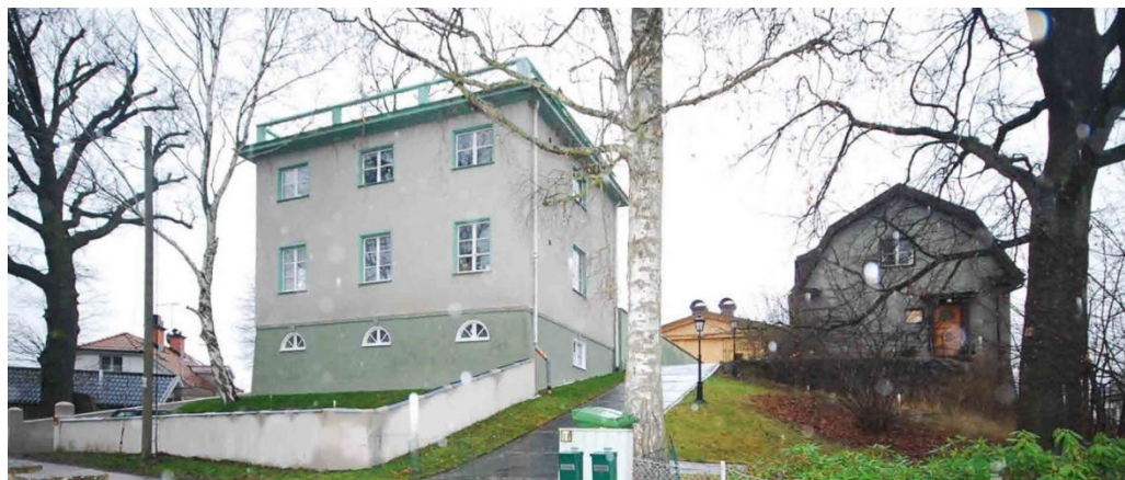
Islinge udde 4. Jacob Gate är arkitekt till denna villa som byggdes 1930. Villan har en egen profil bland uddens 1920-talsvillor genom sin större volym och starka koppling till italiensk klassicism.
