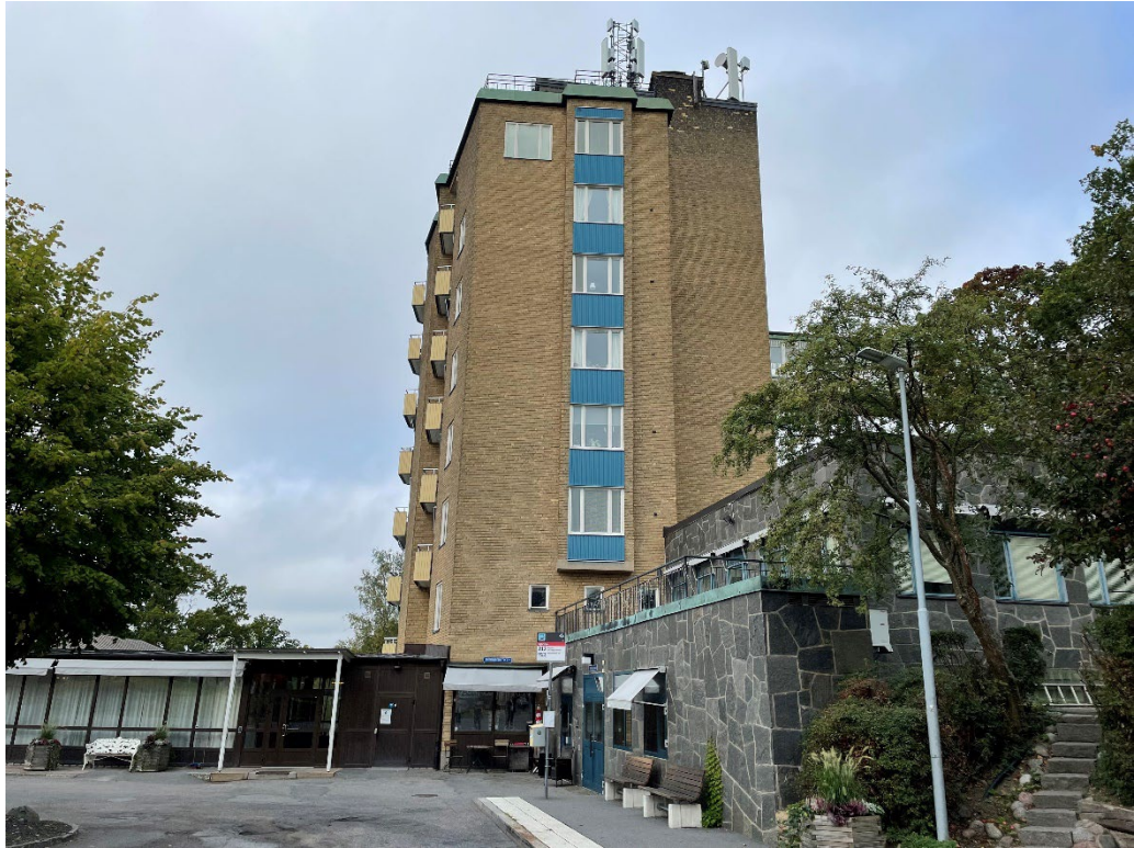
Björnbos huvudentré med punkthus och tidigare tvätt till höger i bilden.
