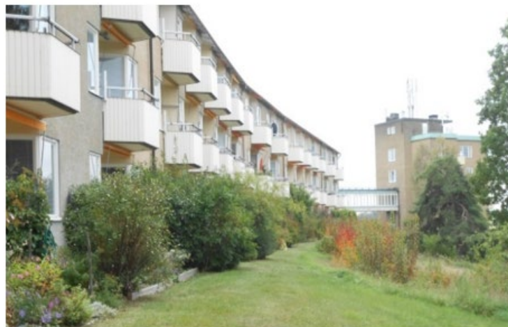
Borggårdens västra länga och höghuset i fonden. På bilden syns den sammanlänkande matargången mellan husen.
