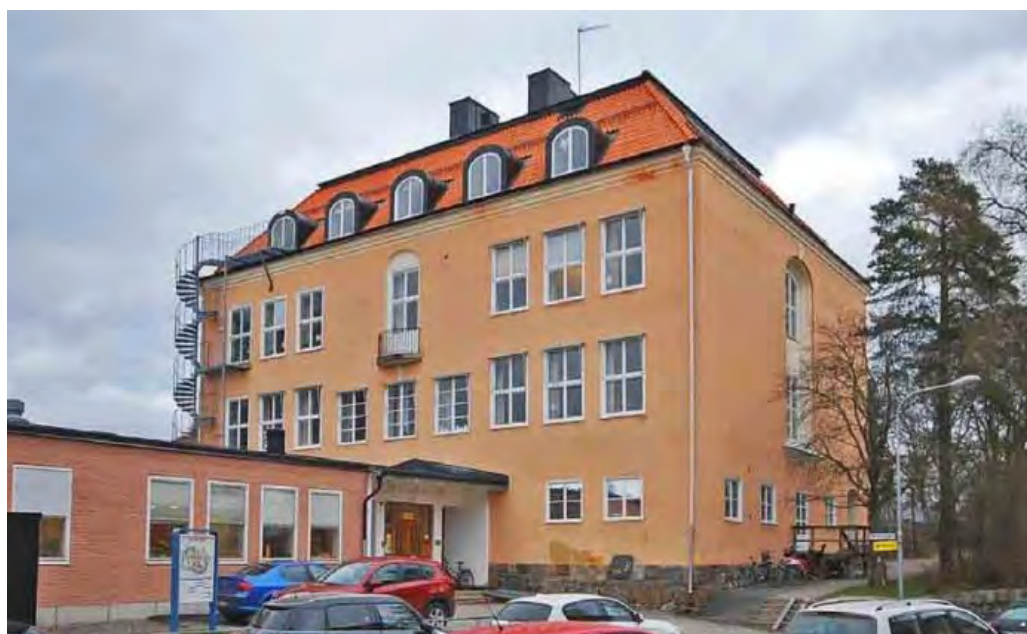
Torsviks skola. Den äldsta byggnadsdelen är från 1906.
