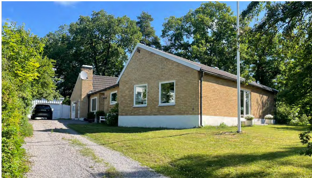
Mölnahöjden 9 från 1955 är ritad av arkitekt Tage Lycknert och är den enda i området med fasad i gult tegel.
