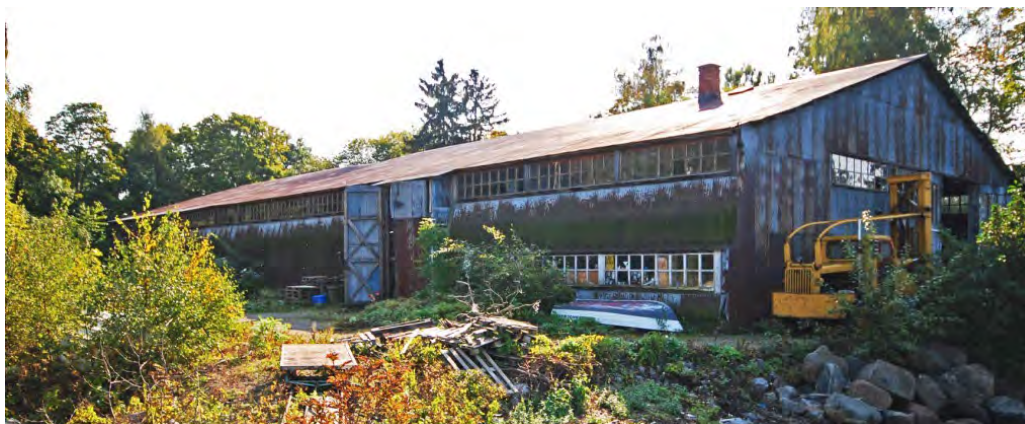
Stora Paravanskjulet från 1930-talet, som använts inom försvarets minhantering på ön, är genom sitt ursprung en kulturhistoriskt intressant industribyggnad.
