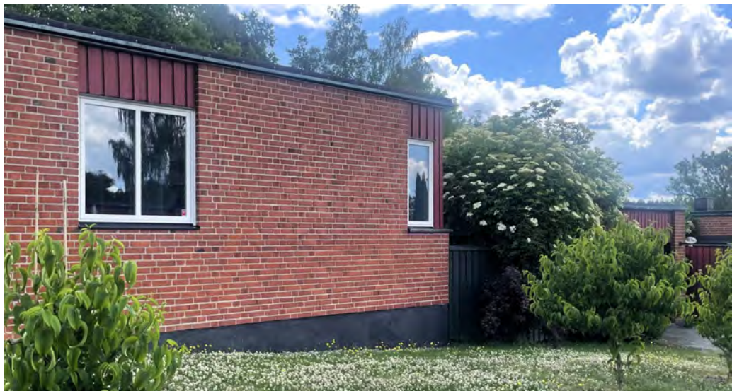
Atriumvillorna vid Boholmsstigen.
