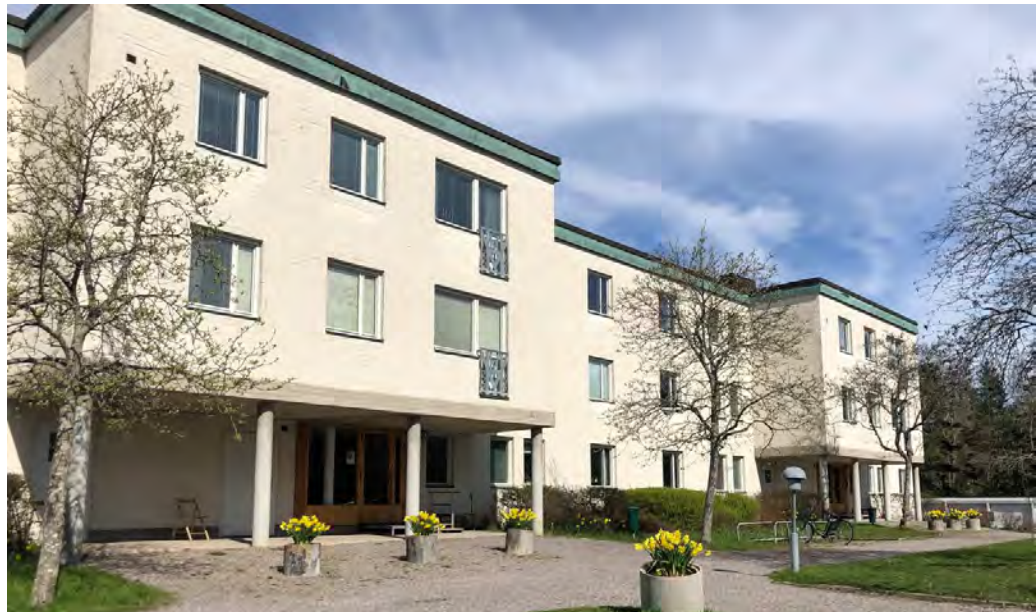
Ett av Pelarhusen inom kvarteret Lodjuret.
