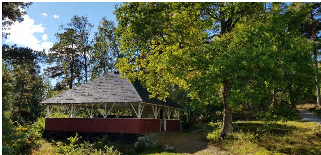
Dansbanan i skogskanten uppfördes på 1930-talet och renoverades på 1990-talet.
