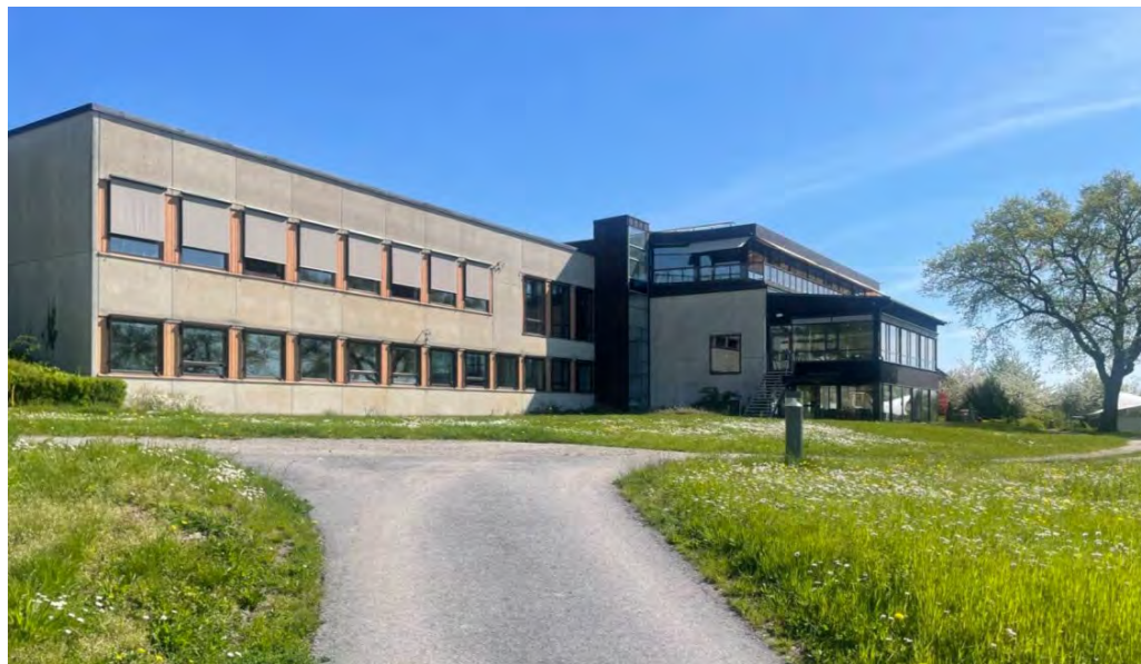
Rönneberga kursgård, huvudbyggnadens fasad mot sjösidan.
