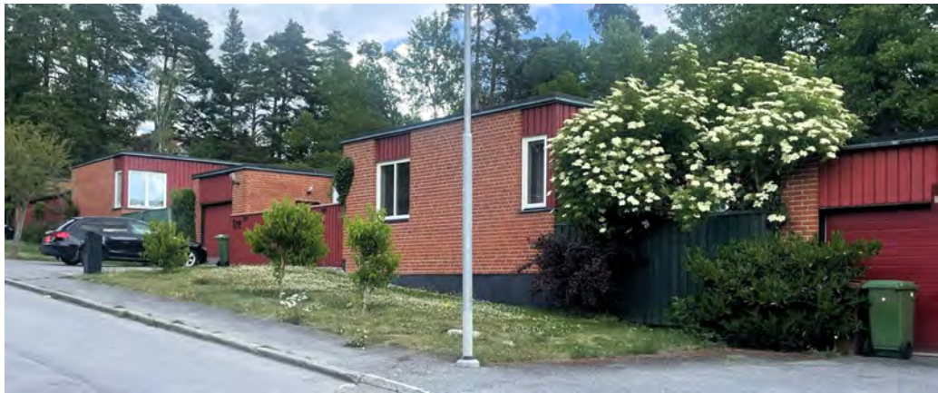
Atriumvillorna vid Boholmsstigen.
