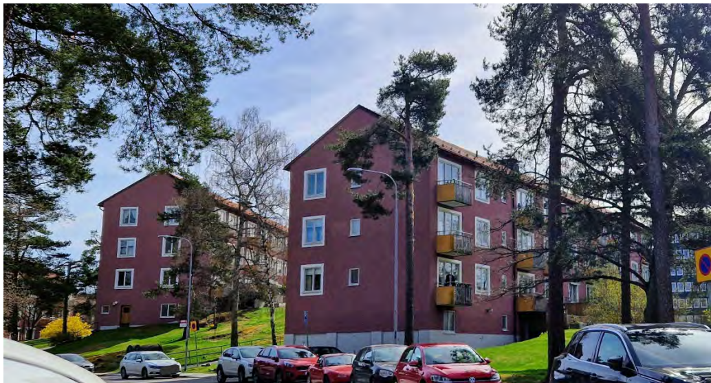
Kvarteren Torsdammen och Torselden. Lamellhusen från 1946–1947 är snedställda mot Torsviksvägen vilket bidrar till att ge gaturummet i områdets sydöstra del en speciell karaktär.
