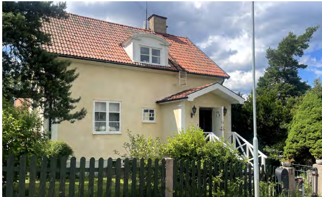
Lappland norra 1 är ritad av Einar Rudskog 1933 och bär stark karaktär av 1920-talets lätt klassicistiska villaideal. Slätputsade hörnlisener, profilerad taklist och takkupa och regelbundet placerade spröjsade fönster i liv med fasaden sätter prägel på exteriören.
