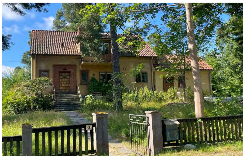
Åsen 19 är ritad av Einar Rudskog 1939 och har ett expressivt uttryck med tydligt klassicerande anslag med den profilerade gesimen som bär upp taket och entrédörrens tunga omfattning i tegel.
