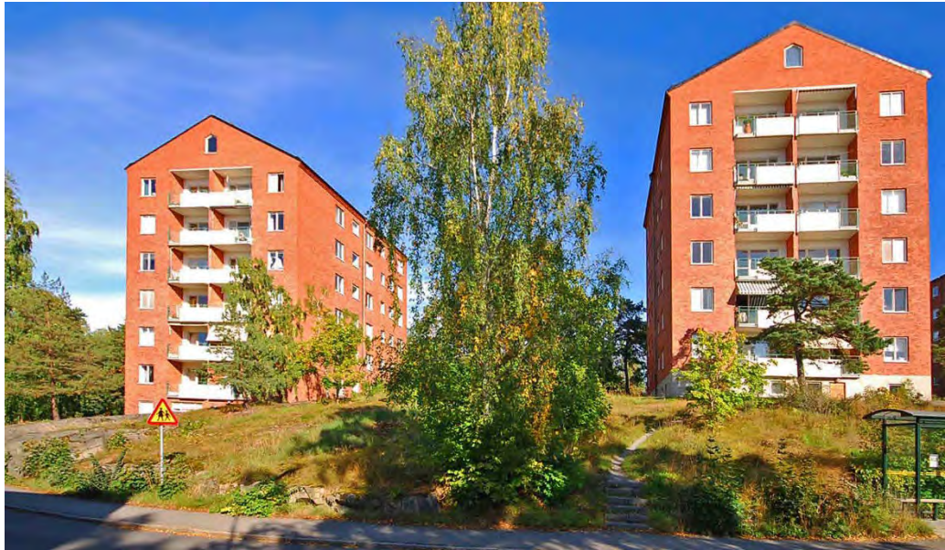
Torsborgen 3 och Torsklinten 1.
