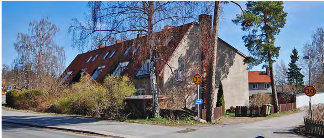
Kv. Poppeln från Södra Kungsvägen med sina asymmetriska sadeltak och indragningar i bakre takfallen.
