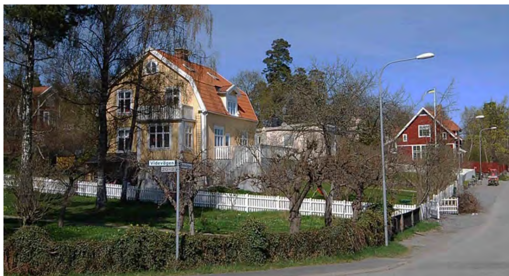
Banvägen vid Murgrönan 17, 14 och 15. Vy mot nordost.
