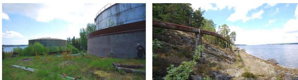
Till vänster: Övre cisterngården. Till höger: Pipelinesystemet i norr, som går från Oceanbryggan.
