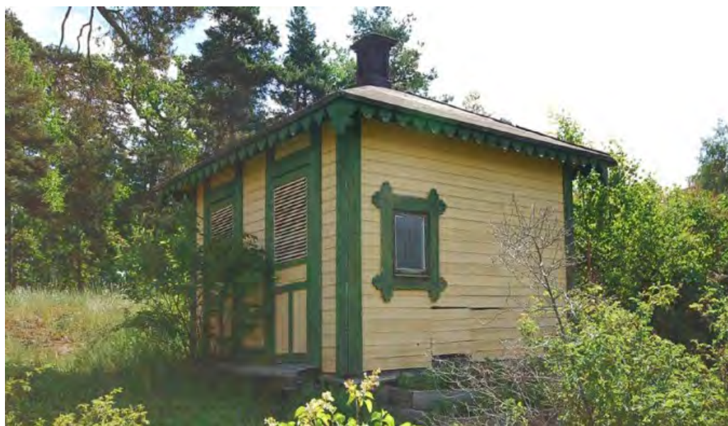
Lidingö 6:71. På ängen mitt inne på ön står detta välbevarade dass i tidstypisk panelarkitektur från sent 1800-tal.
