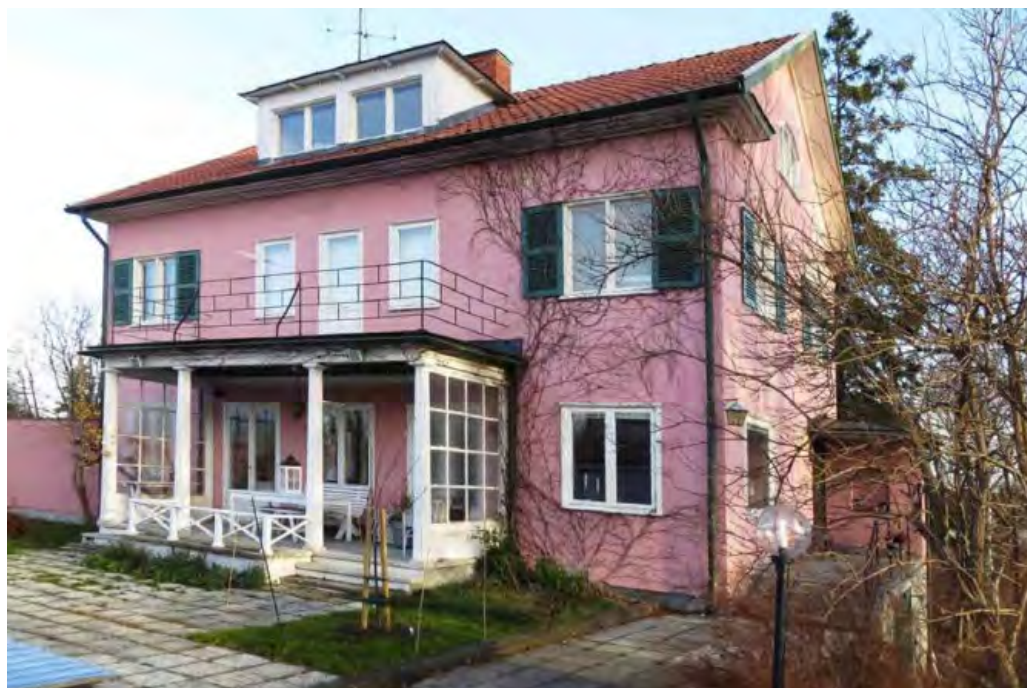
Hjässan 9 ritad av Einar Rudskog 1935 och har en klassicerande loggia med lågt kryssräcke och stora profilerade taksprång. Den rosa putsen är lekfull och samspelar fint med de gröna fönsterluckorna.
