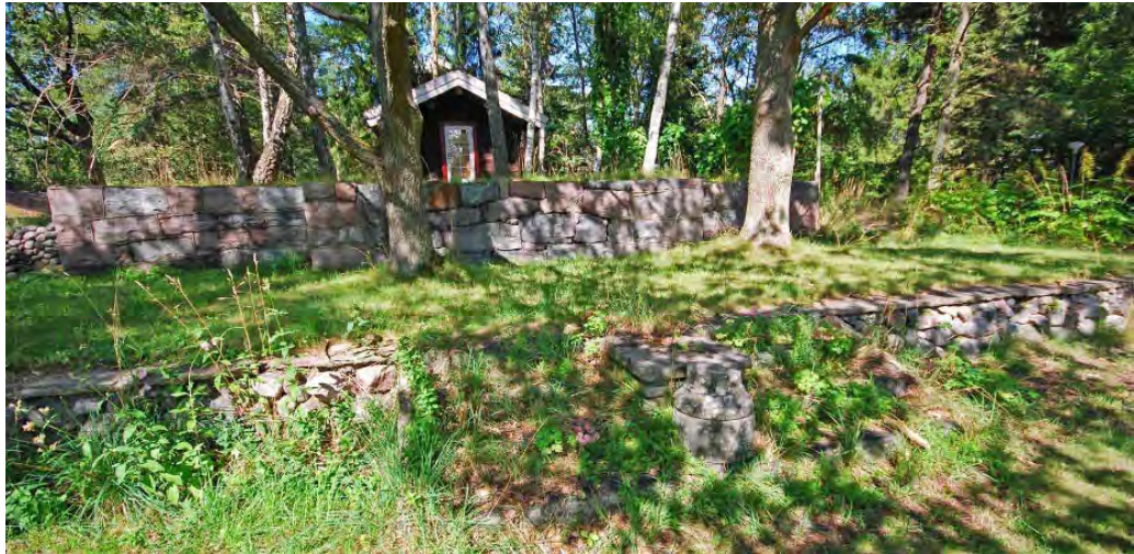
Den stora husgrunden till sommarvillan Villa Metsola från 1893 finns kvar, en mäktig stenmur med terrasseringar.
