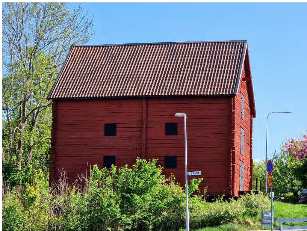
Längre söderut från kyrkan står Hersby gårds stora faluröda timrade spannmålsmagasin från tidigt 1800-tal.
