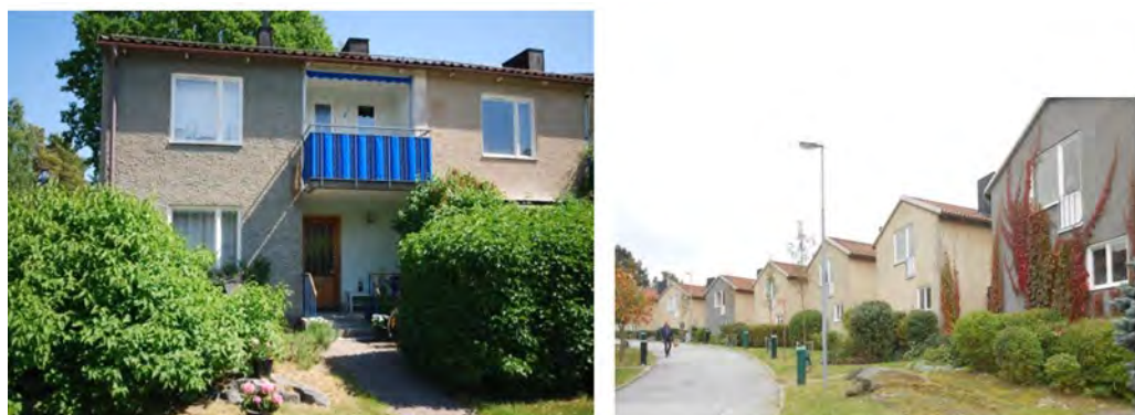
Radhuslänga med dörr i ek, smidesräcke vid entrén och plansteg i granit. Kedjehusen har fasader med en grov puts och kulörerna är jordnära och varma.
