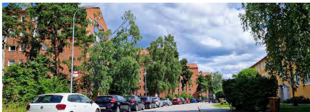
Punkthusen i kvarteret Torshammaren.
