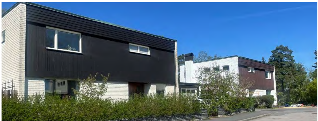
Fasaderna är i vitslammat tegel och brunlaserad stående panel. Den breda takfoten markeras med liggande panel under ett papptäckt platt tak. Garage och förråd i en våning är vidbyggda ena kortsidan. Fasaden i stående panel är antingen vitmålad eller brunlaserad. Misteln 4 och 14.
