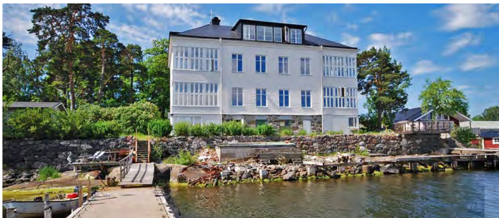
Stenvillan, fasad mot vattnet.
