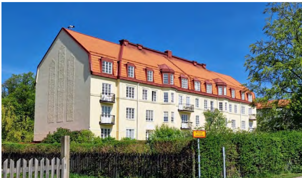
Blocket 7 med sin karaktäristiska ljusa putsarkitektur från 1914. Arkitekt Ivar Nyqvists arkitektbyrå.
