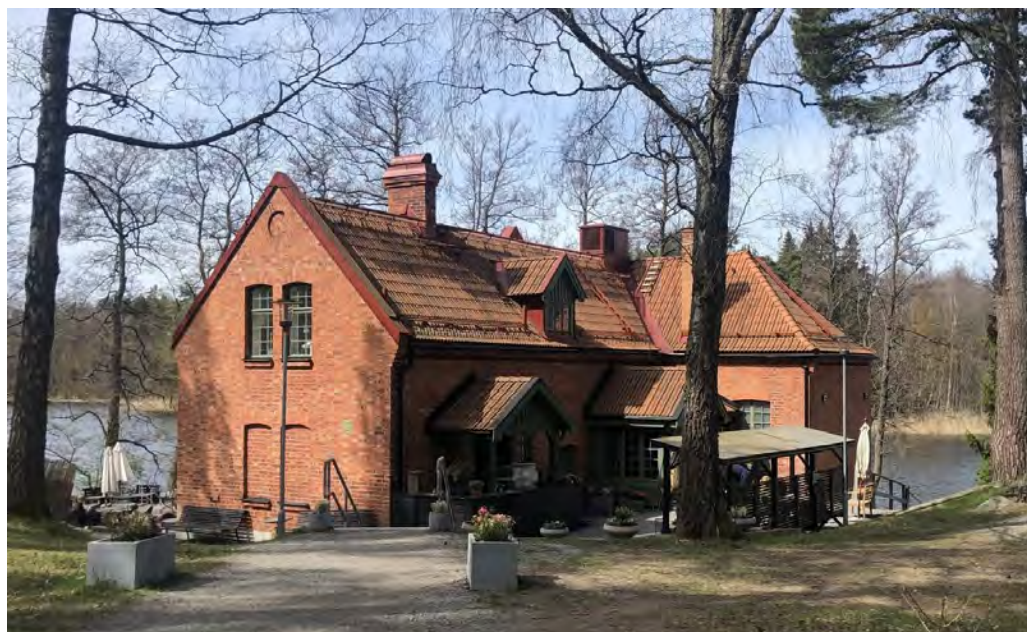
Vattenverket vid Kottlasjön uppfördes 1910 och den tidstypiska industriarkitekturen är fortfarande påtaglig. Idag används Vattenverket som café.
