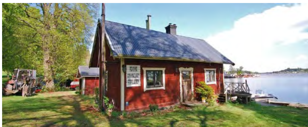
Det lilla bostadshuset i ost/sydost från ca 1905, i dag en av öns äldsta byggnader.
