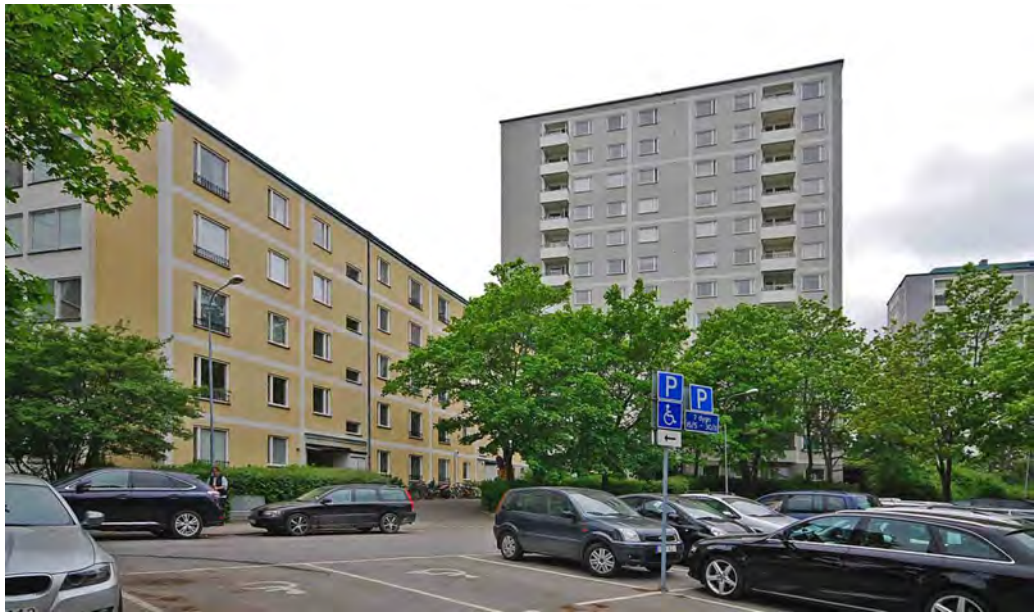
Briggen 1 och 2. Punkthus och lamellhus uppförda 1958–1962.
