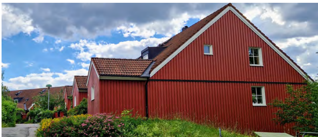
Ängsklockevägen från 1970-talet.
