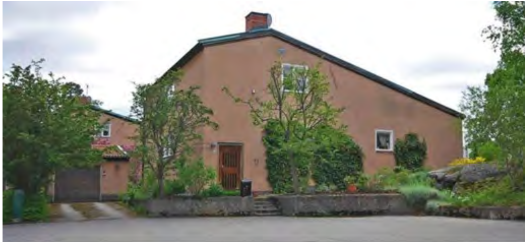
Längs Järpstigens sydvästra sida ligger fyra enhetligt utformade villor. Orren 14-17. Husen uppfördes i två våningar 1962-1963. Orren 16.
