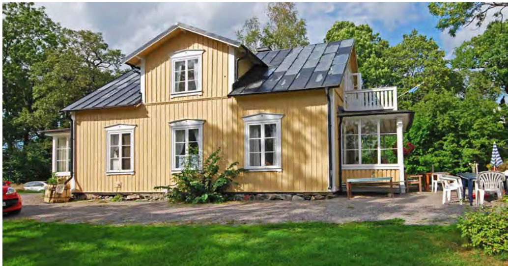
Sjövillan på Hustegaholm byggdes som vaxljusfabrik 1832 och byggdes om till bostad redan 1847. Sjövillan är i dag den enda mer ursprungligt bevarade äldre byggnaden på Hustegaholm och är av mycket stort kulturhistoriskt värde. (Lidingö 5:136).
