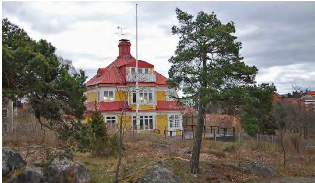
F.d. Iherfeldtska barnhemmet, från ca 1900, en rest av sommarvillabebyggelsen på Torsviksbranten (Brofästet 6).
