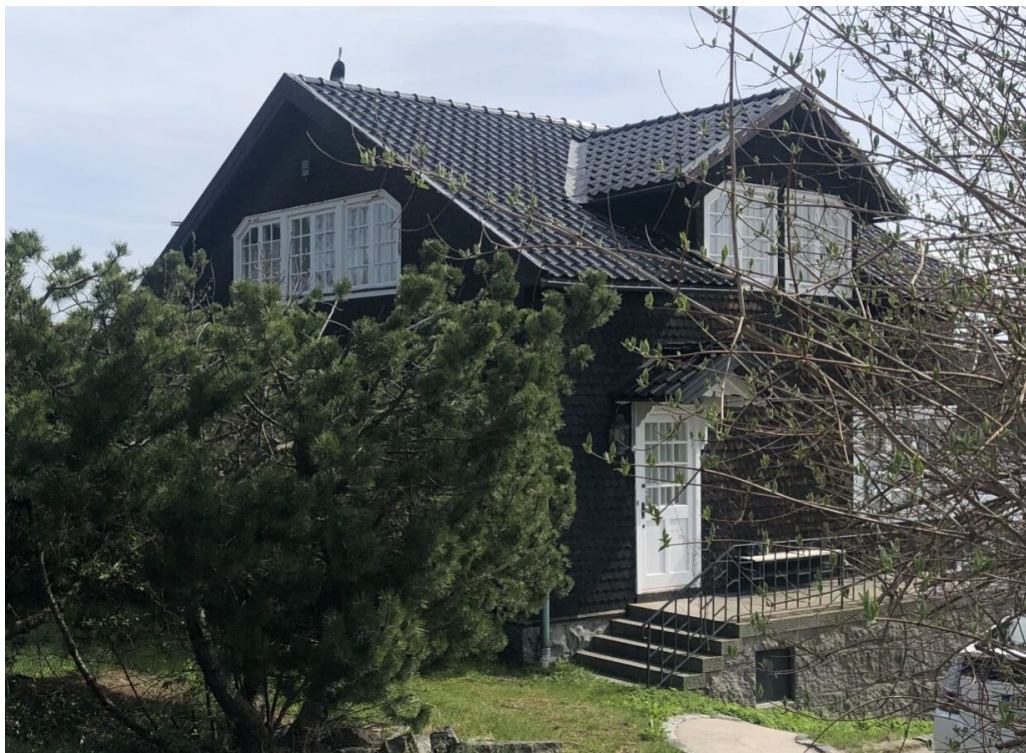
På 1910-talet byggdes flera andra villor i området. En speciell karaktär har den svarttjärade Utsikten 24, ritad av arkitekt Ferdinand Boberg.
