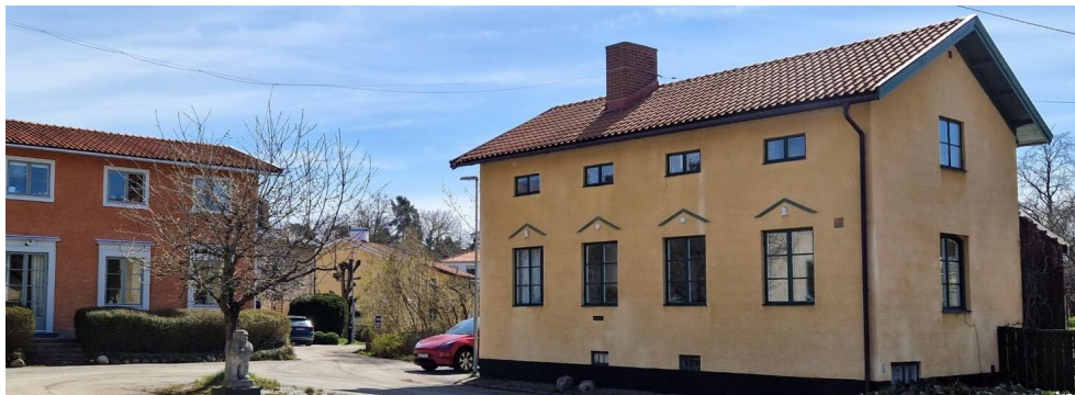
Bygge & Bo är ett av Lidingös tre riksintressen för kulturmiljövården.
