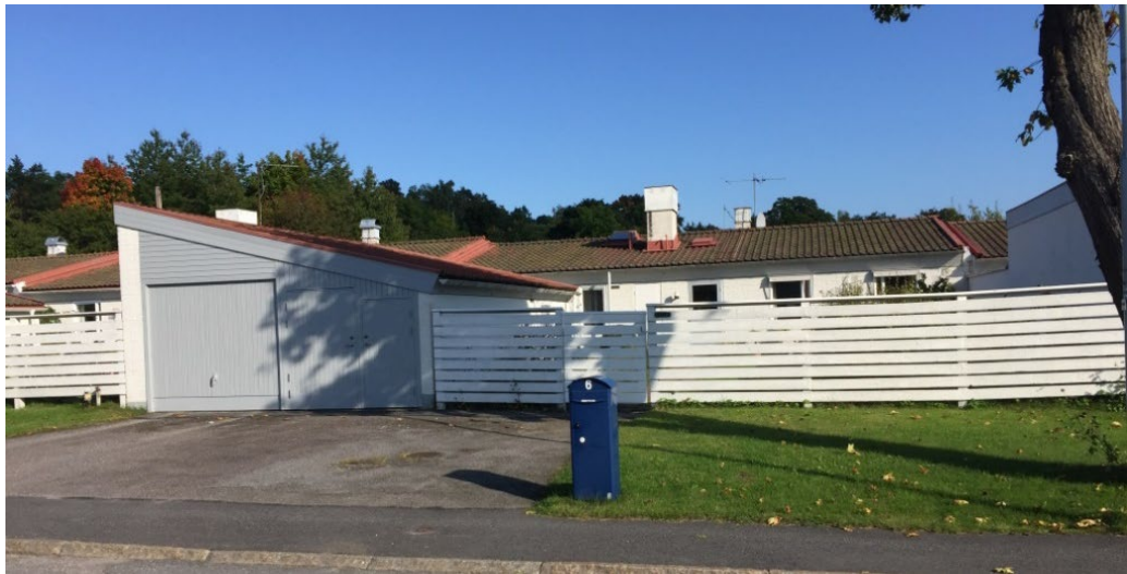
Kvarteret Spantet, fasad mot gatan.
