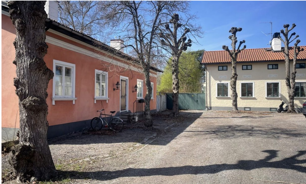
Det inre grusbelagda torget i Bygge och Bo.
