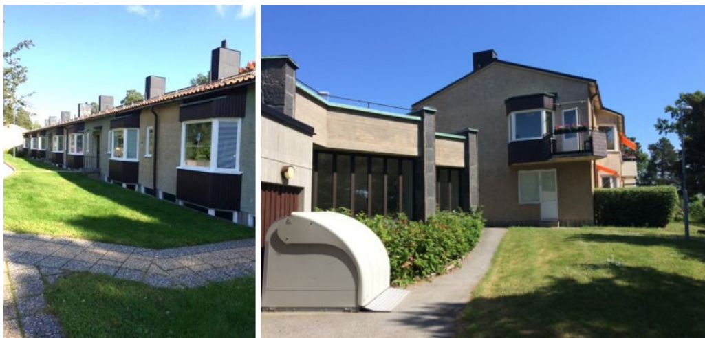
Hus i souterräng.
