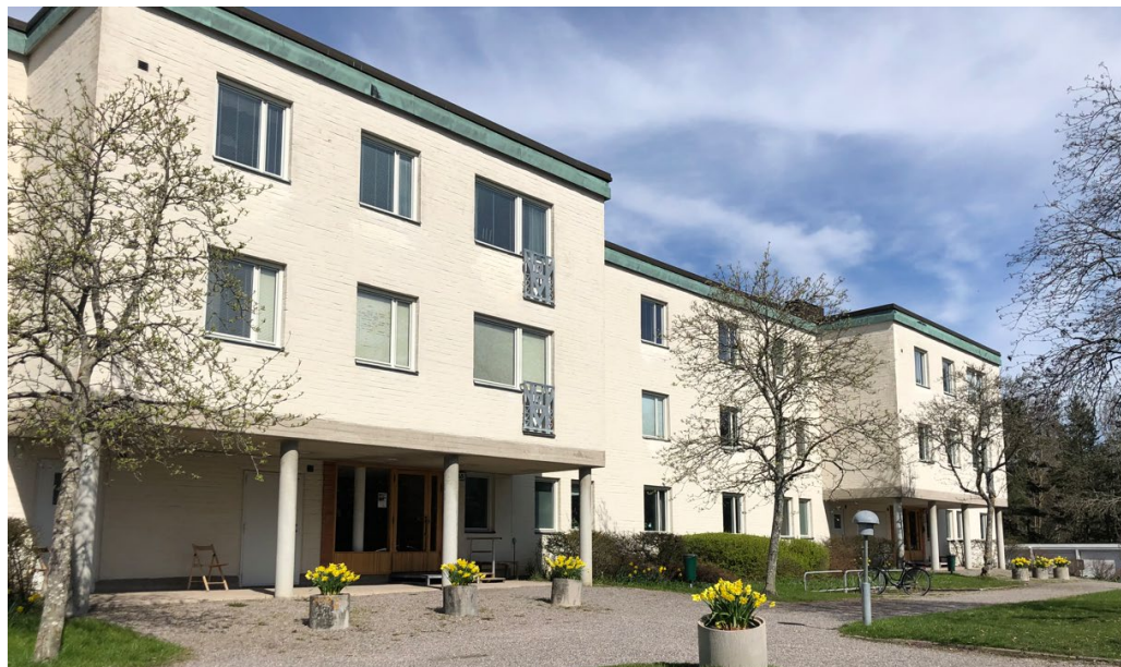
Ett av Pelarhusen inom kvarteret Lodjuret.
