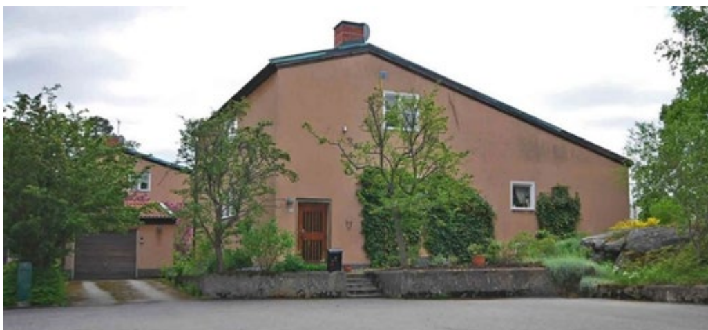
Längs Järpstigens sydvästra sida ligger fyra enhetligt utformade villor. Orren 14-17. Husen uppfördes i två våningar 1962-1963. Orren 16.
