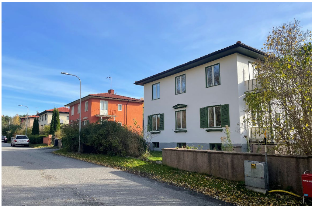
Villorna är alla utformade som kuber med tälttak med tegel och tydliga taksprång och främst tvåluftsfönster. I förgrunden Sigyn 12.
