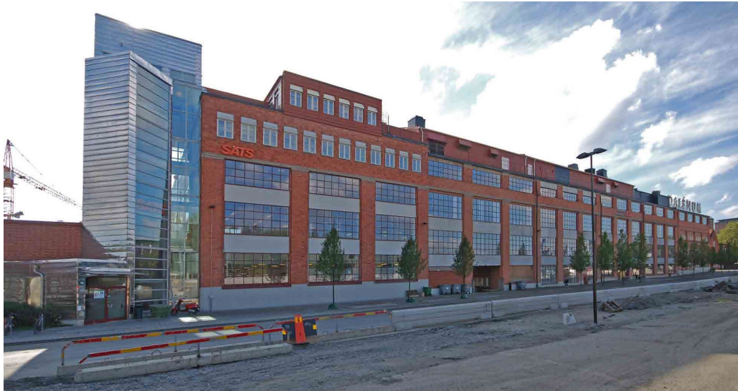
Byggnaderna 113, 112 och 111, de gamla verkstadsblocken III-I, efter om- och tillbyggnad.
