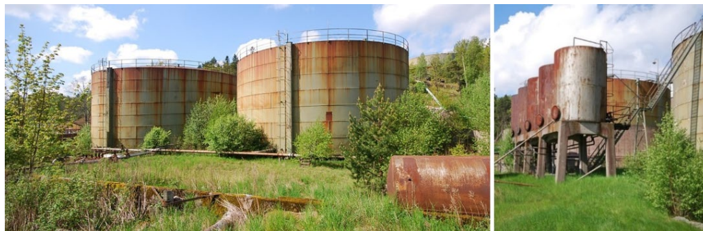
Till vänster: Östsidan med oljecisterner från tidigt 1900-tal. Till höger: Små cisterner från troligen 1903–1907.
