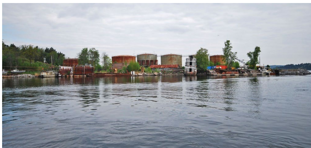
Östra udden med ytterst de fyra cisterner som flyttades dit 1921 och innanför de äldsta cisternerna från 1903–1907.
