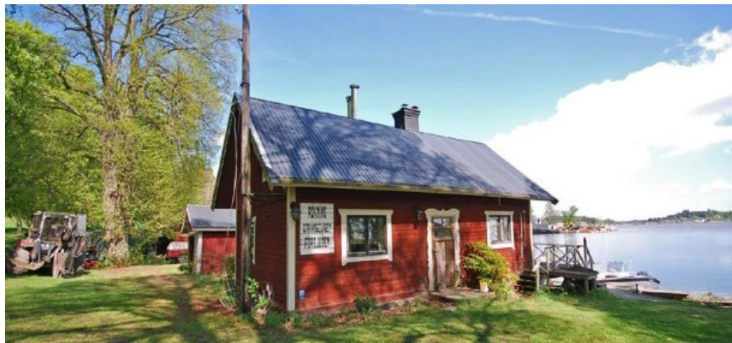
Det lilla bostadshuset i ost/sydost från ca 1905, i dag en av öns äldsta byggnader.
