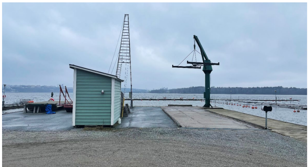
Kran och spolplatta inom hamnområdet.
