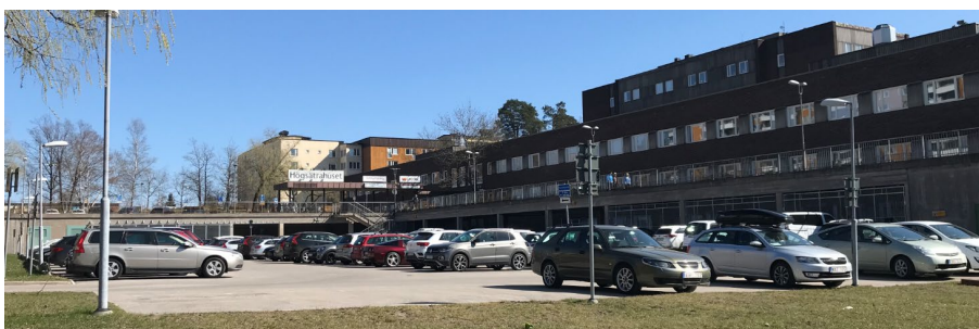
Högsätrahusets entré med parkeringsplatser framför.
