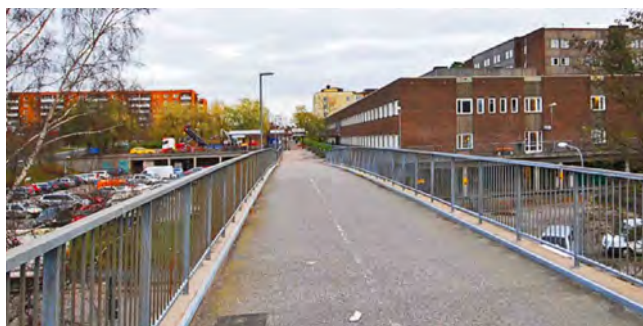
Befintlig gångbro över Läroverksvägen och Lerbovägen.
