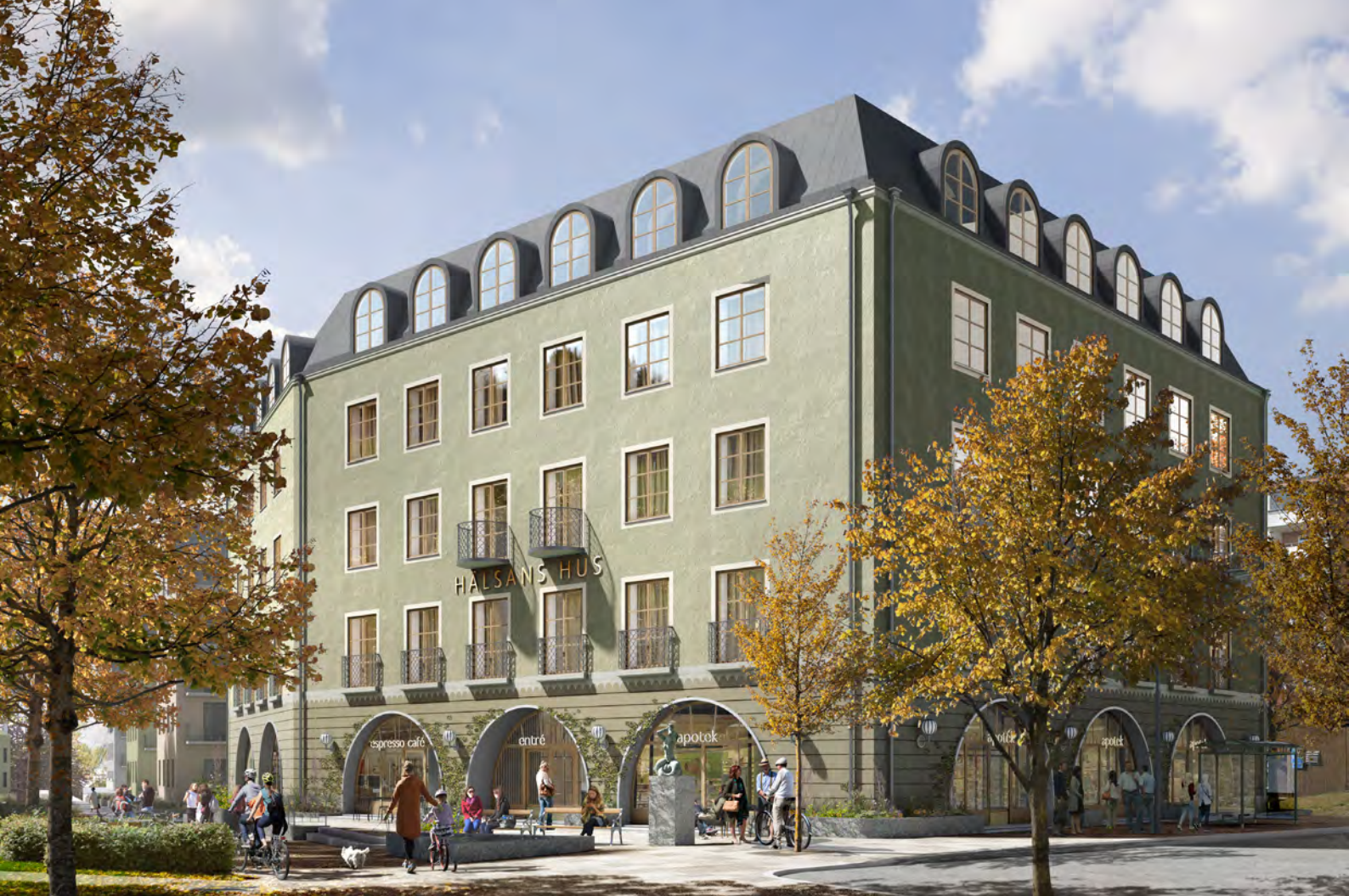
Vy mot torget och bussvändplatsen. Byggnadens södra, sydöstra och nordöstra fasad. Bild: Brunnberg och Forshed.
