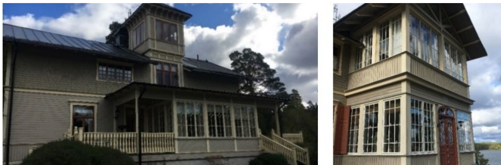
Bild till vänster: På fasadens västra sida finns ett torn. Verandan är ett senare tillägg, men både öppna och glasade verandor är typiska för byggnadstypen. Bild till höger: Inglasad entréveranda i två våningar med småspröjsade fönster och dekorativt utformad entréport.
