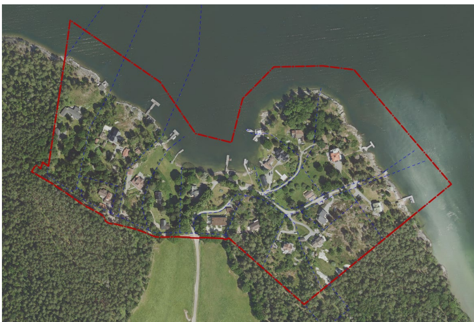
Flygbild med planområdet markerat med röd linje. Fastighetsgränser markerade med blå linjer.
