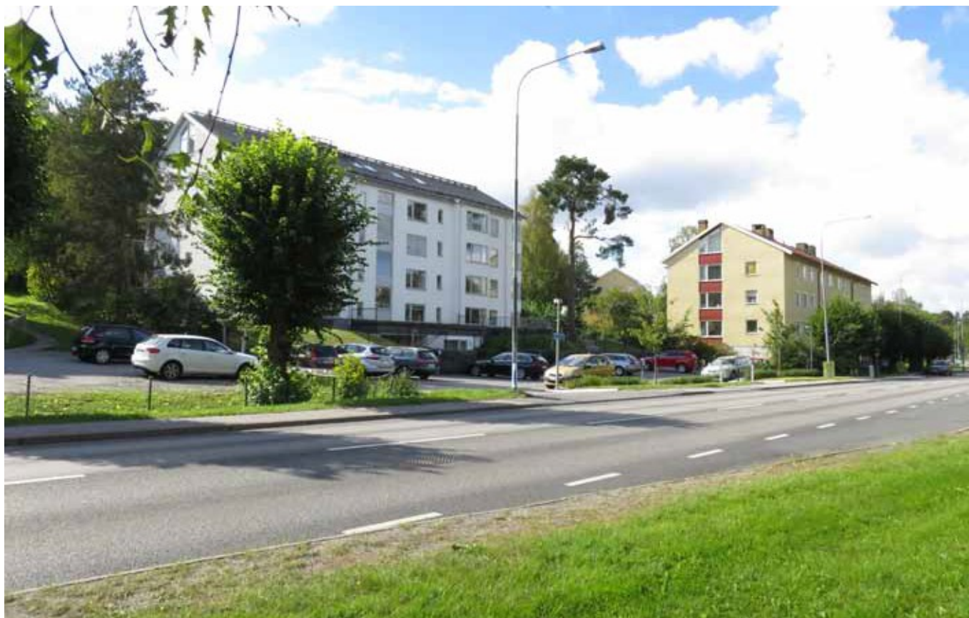
Lindallé Kyrkvägen, sikt från nordväst. I mitten finns luckan vid det nybyggda flerbostadshuset och parkeringsplatsen.
