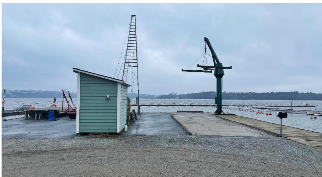
Kran och spolplatta inom hamnområdet.
