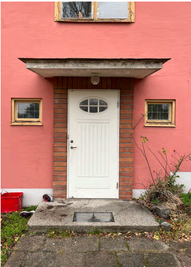
Entrén vid södra fasaden med ett rakt skärmtak och tegelomfattning runt dörren.
