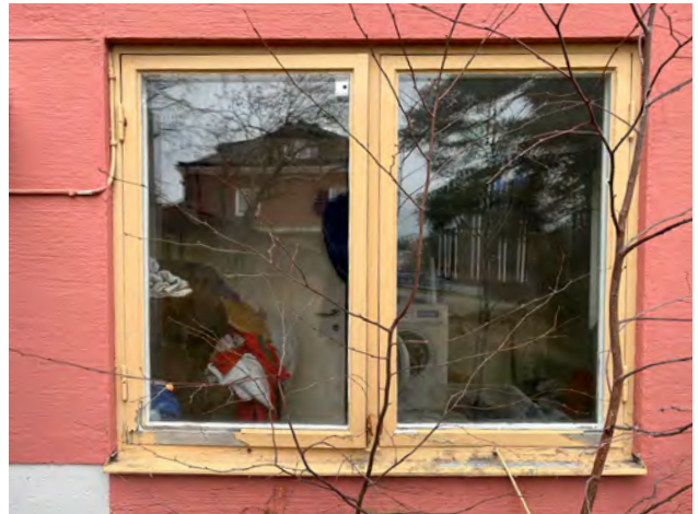
Rektangulära tvålufts-fönster med utåtgående bågar. Fönstren är ursprungliga träfönster från byggnadens uppförandetid med tidstypisk utformning med varierande luftindelning. Dessa snart 100-år gamla fönster är av hög kvalitet, och deras proportioner och detaljer är av vikt för byggnadens karaktär.
