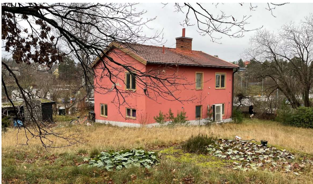
Lejonet 29, foto taget inifrån trädgården i december 2024. Villabyggnaden är uppförd på 1940-talet. I bakgrunden skymtas drivmedelsstationen OKQ8 samt Södra Kungsvägen.
