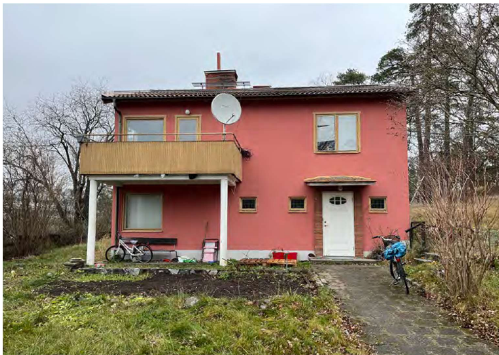
Huvudbyggnaden sedd från Drottningvägen/söder.
