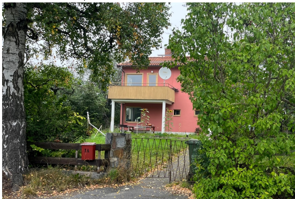
Bilden visar fastigheten med den nuvarande byggnaden. Bilden är tagen från sydväst.
