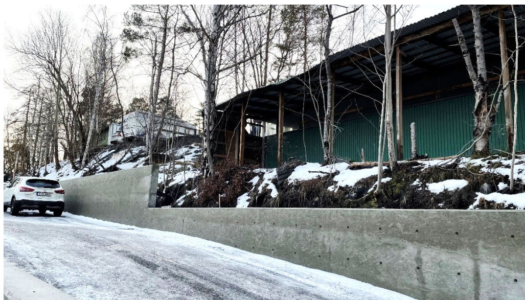
Fastigheten Lyftkranen 2 med slänt som möts av ett L-stöd av betong på intilliggande fastighet Lyftkranen 3.
