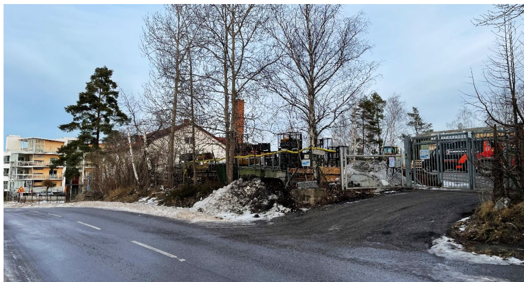
Fastigheten Lyftkranen 2 sedd från Södra Kungsvägen, vy från väster. Byggbolaget NCC har tillfälligt upplag här under det pågående arbetet med att uppgradera Käppalaverket.
