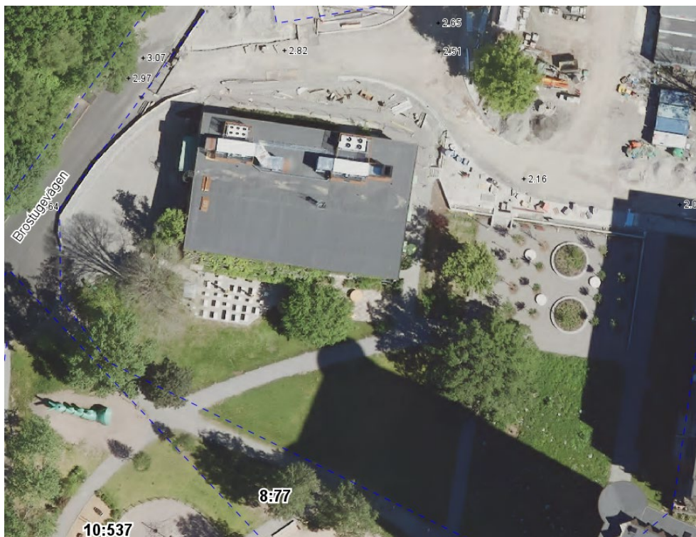
Snedbild från 2022 som visar den nyligen anlagda Agaparken söder om Sjövillan, samt parkeringsytan vid Sjövillans västra gavel.
