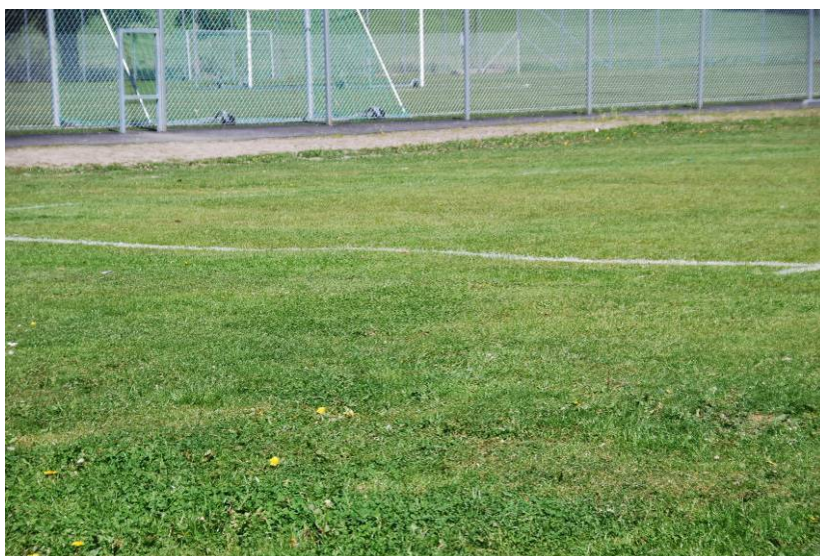
Figur 29. Pågående sättningar för bollplan i Brevik
