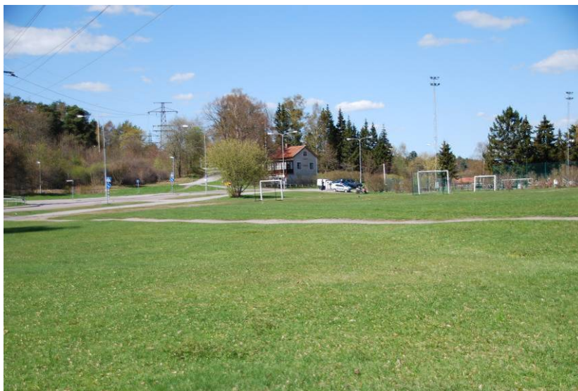
Figur 28. Pågående sättningar i Kyrkviken efter markuppfyllnader
