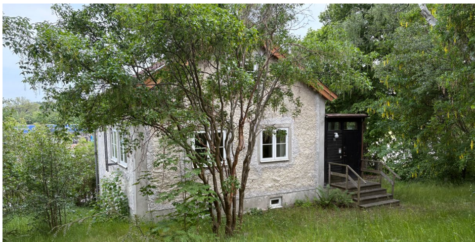
Byggnaden på Lidingö 5:140 sedd från väster.
