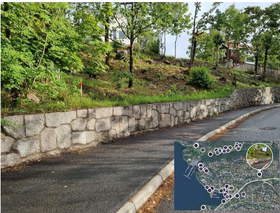
Figur 37. Stödmur vid Rosavägen.
