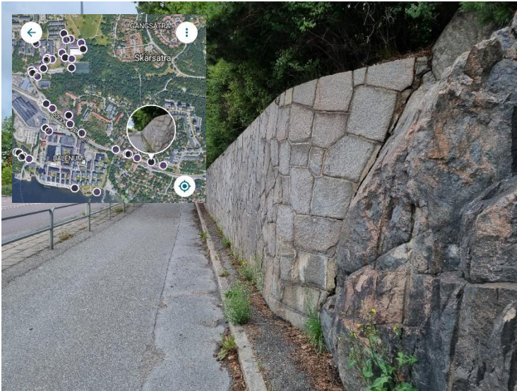
Figur 21. Stödmur längs med S:a Kungsvägen.
