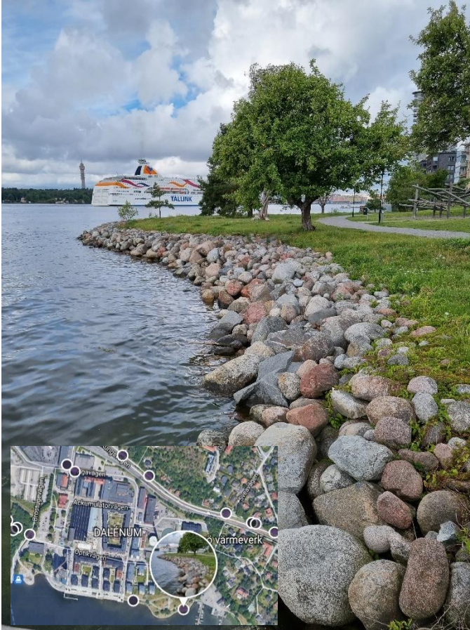
Figur 25. Erosionsskydd längs med strandlinjen i södra Dalénum.
