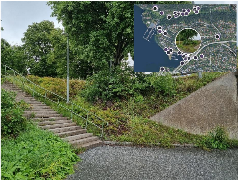
Figur 36. Slänten vid GC-tunneln som korsar N:a Kungsvägen.
