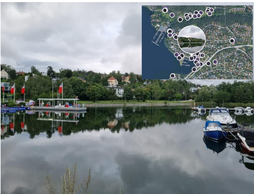
Figur 41. Översiktspå bild på erosionsskyddet längs med strandlinjen vid Islinge hamnvägen.
