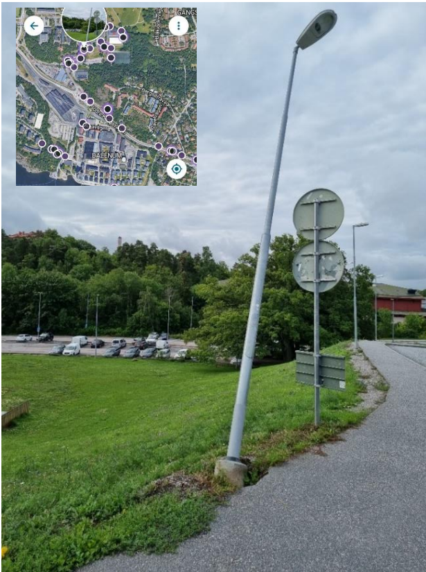
Figur 17. En ljusstolpe visar tecken på bärighetsproblematik vid släntkrön i söder om Högsätra skolområde.
