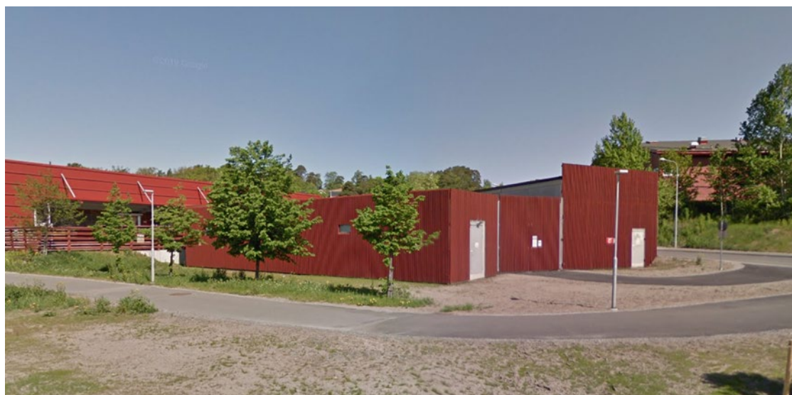
Bilden visar ombyggnation av fördelningsstationen Gångsätra.
