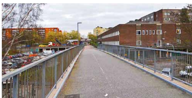
Befintlig gångbro över Läroverksvägen och Lerbovägen.
