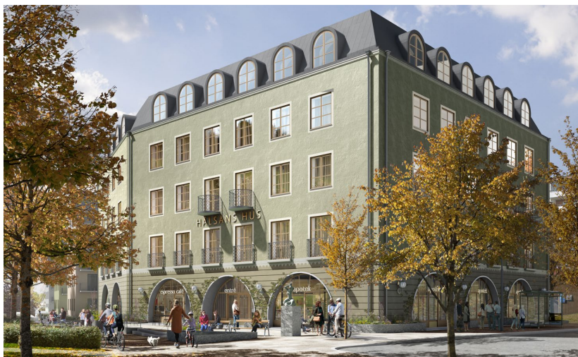
Hälsans hus sett från bussvändlingen. I bilden syns torget och Hälsostråket vänster i bild. Bild: Brunenberg & Forshed.
