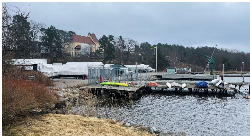
Småbåtshamnen sedd västerifrån.
