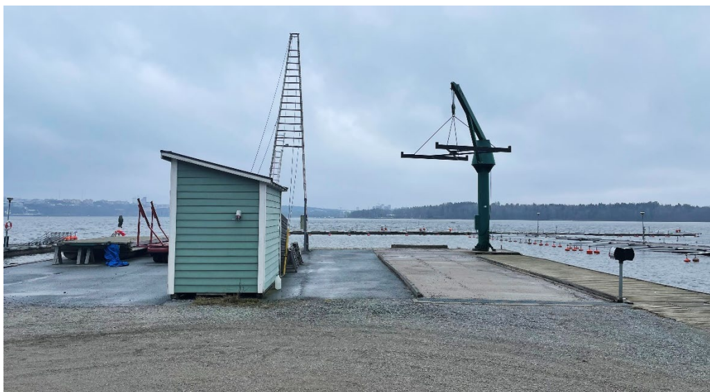
Kran och spolplatta inom hamnområdet.
