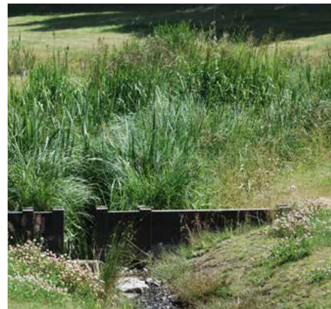
Översvämningssmark med dike och enkelt dämme, Tollare park. Foto: WSP
