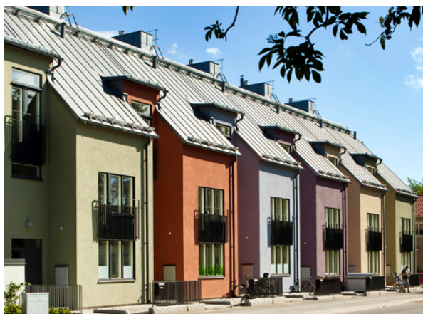
Radhus i puts med avskiljande färgsättning
