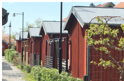
Förrådsbyggnader på radhustomter
